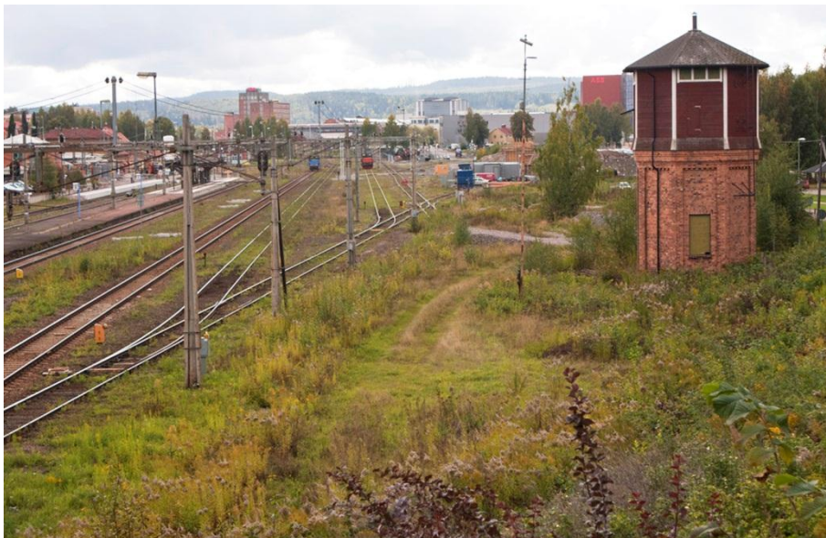
Översikt mot norr. ”Ängen” är hitom vattentornet och som den såg ut före röjningen. Foto: Janolof Hermansson
