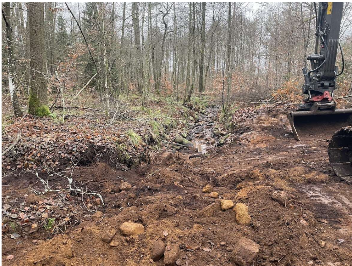
Figur 5. Arbete med igenläggning av den gamla dikesfåran efter att vatten letts om till den nygamla fåran, vy från öster mot väster. November 2024.
