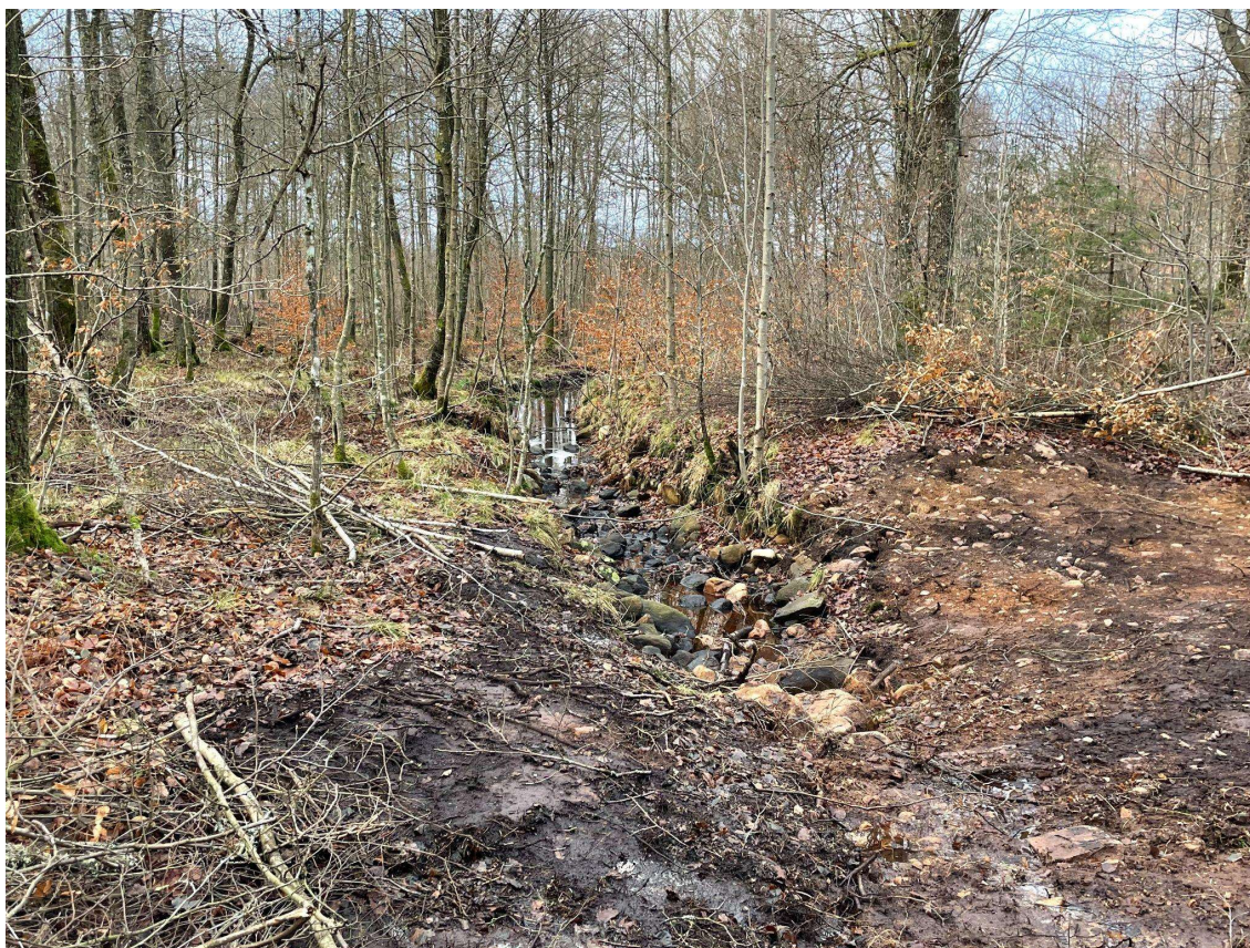
Figur 6. December 2024 efter regn. Vy från öster mot väster.
