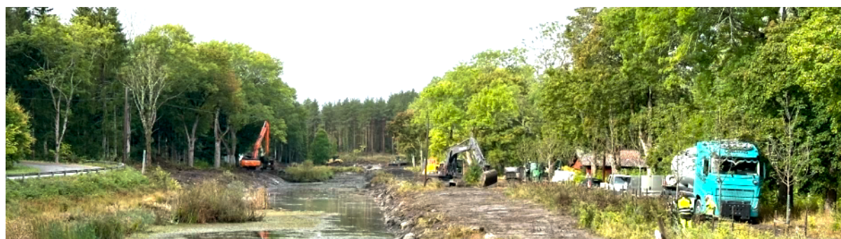
Canalen mot väster under arbetets gång
