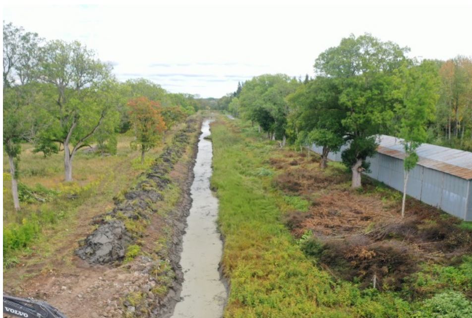
Canalen mot öster i starten av arbetena
