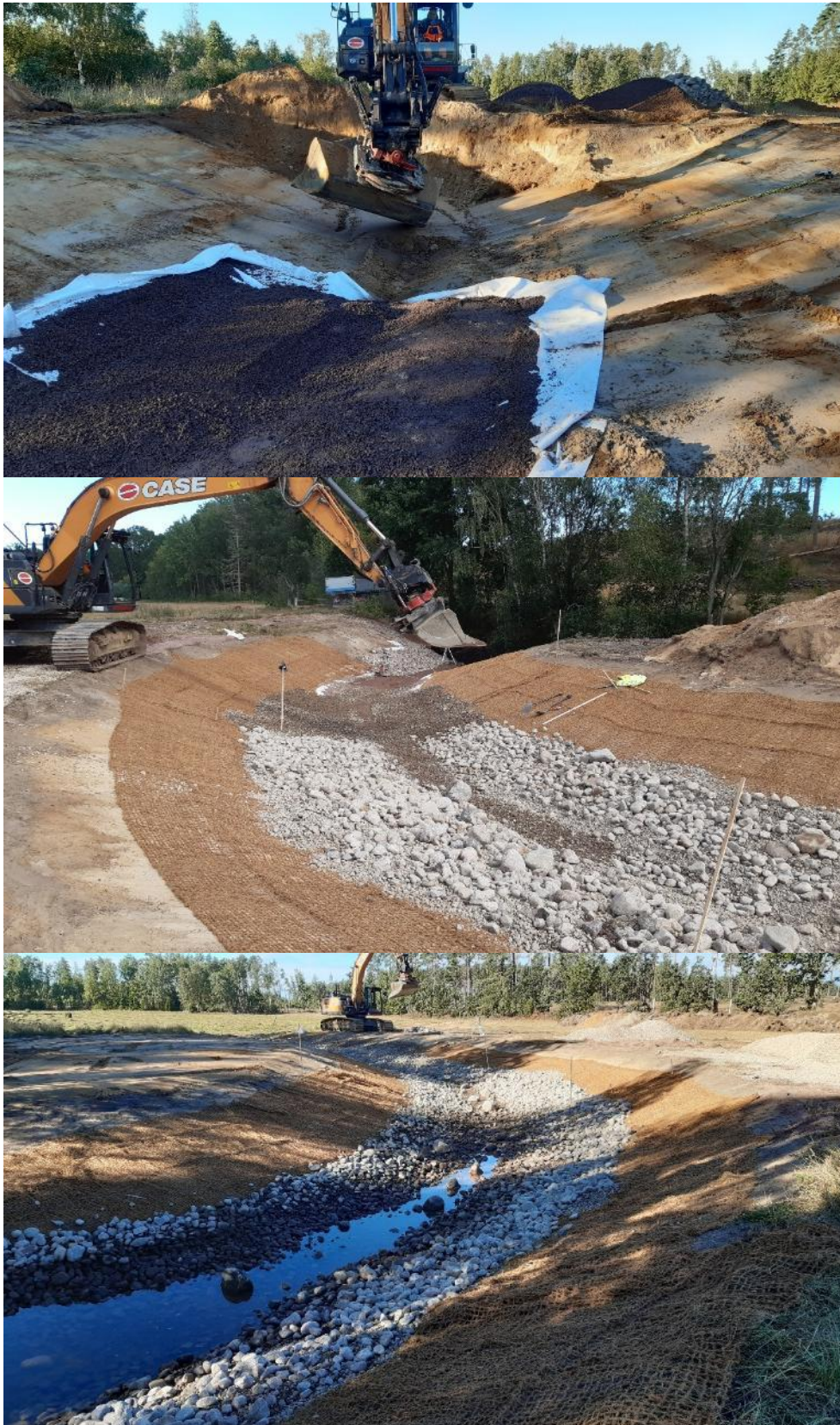
Figur 7. Anläggande av ca 60 meter lång fiskpassage med svag lutning. Eftersom jordarten utgjordes av lös finsand användes markduk innan bergkross lades på och paddades. Därigenom byggdes en tät och fast botten. Därefter tillfördes olika fraktioner av natursten överst. På de sandiga slänterna fästes nät av kokosfiber som ska förhindra erosion fram till dess att vegetation etablerats (kokosfibrerna bryts ner efter några år). Augusti 2022.
