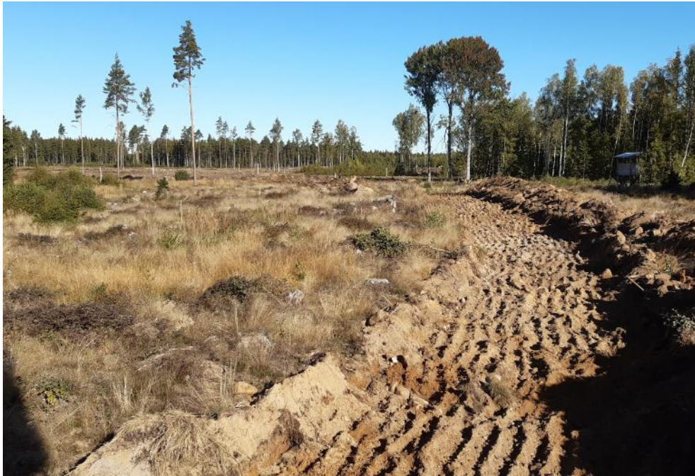
Figur 14. Östra sidan av våtmarksytan (vy mot NV). För att kunna flytta massorna från djuphålan i norra änden fram till platsen där vallen skulle byggas i södra änden behövde en grov körväg skapas genom den ojämna terrängen.
