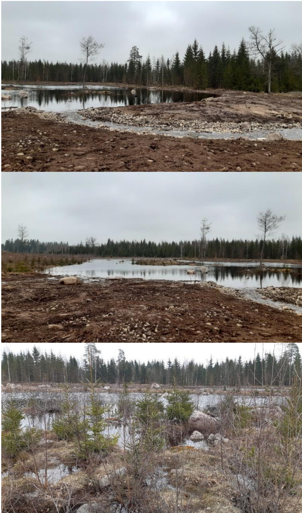
Figur 32. Våtmarken i slutet av februari 2024. Vallen (som går mellan utloppet och eken uppe till höger i den övre bilden) blev mindre jämfört med den norra våtmarken eftersom ytan där södra våtmarken anlades var mindre och mer plan. Ett öppet utlopp med efterföljande strömsträcka anlades även här. Vid hög vattenföring översvämmas marken runtomkring de grävda delarna.
