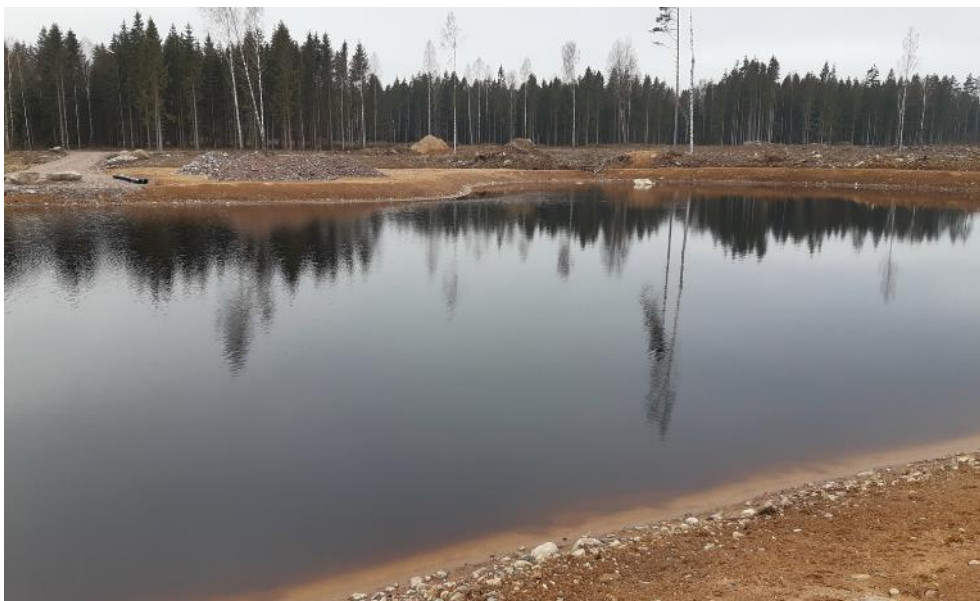
Figur 21. Djuphålan i april 2023. Markägaren gjorde i egen regi i ordning väg och vändplan för att vid behov kunna hämta släckvatten.
