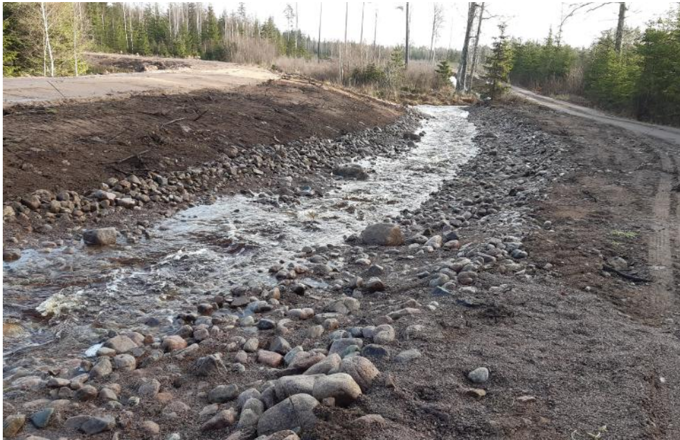
Figur 18. Utloppet från våtmarken gjordes i form av en svagt sluttande strömsträcka som leder vattnet tillbaka till det grävda diket, nu dämt av vallen till vänster i bild. Våtmarken ligger ca 1,3 mil uppströms från kusten så huruvida fisk kommer hitta hit är ovisst. Men oavsett kan en strömsträcka ha en ekologisk funktion samt syresätta vattnet.
