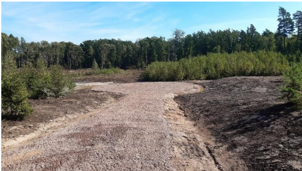
Figur 41. Förstärkning av nedfart samt vändmöjlighet vid djuphålan. Överskottet av massorna från djuphålan lades i en svacka i backen till höger i bild.
