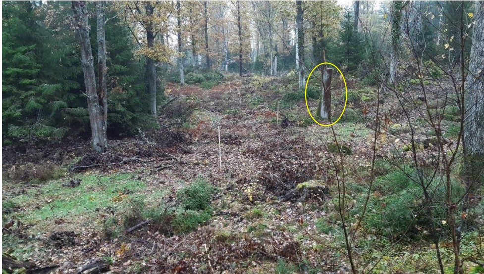
Figur 43. Nedre delen av "gamla fåran" innan grävning. Denna del var relativt plan och har ev. varit ett lugnvatten innan dikningen. För att vattnet inte skulle leta sig tillbaka till det närliggande diket lades detta igen hela vägen längs det nygamla utloppet. Oktober 2023
