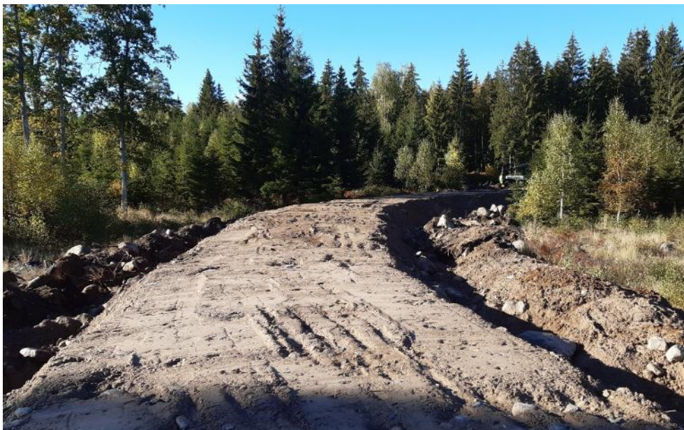
Figur 17. ...och så även vällen. Här i södra änden av våtmarken blev den som högst relativt markytan. Vy mot sydväst, där utloppet senare anlades.
