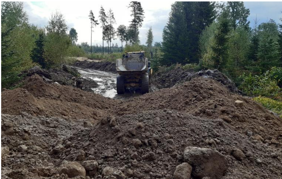
Figur 15. Transport av massorna till vallen, som blev den volymmässigt mest omfattande anläggningen i projektet.
