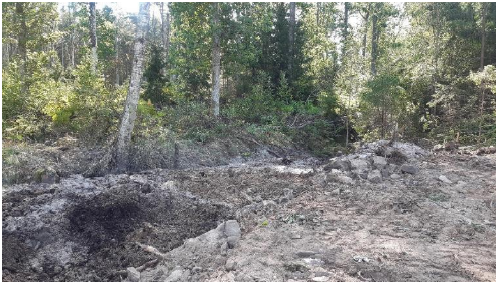
Figur 40. Igenläggning av det grävda diket ut från Hålekärr.
