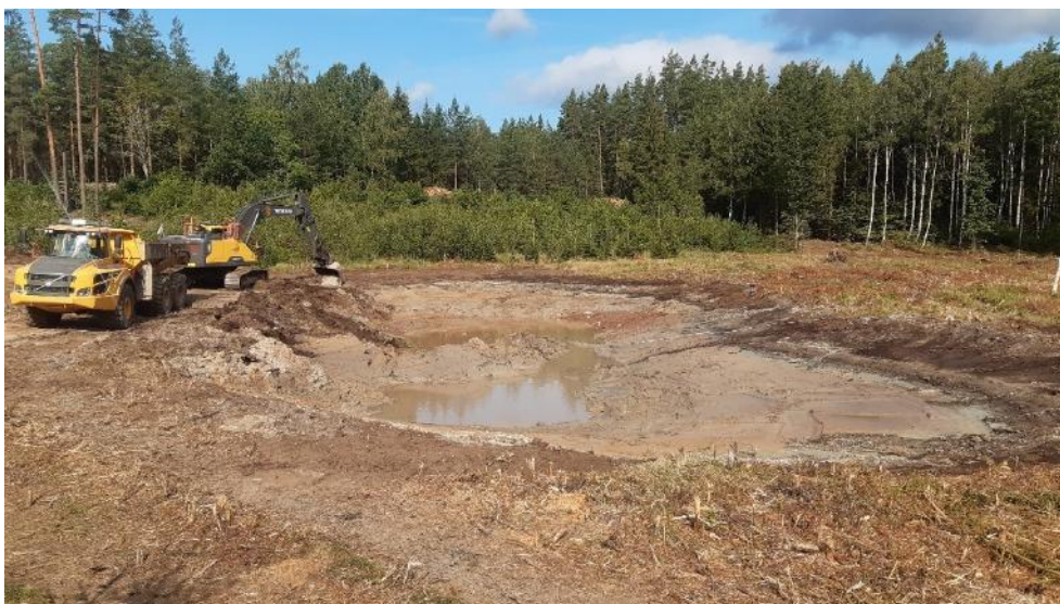
Figur 39. Grävning av djuphåla. Materialet användes delvis för att lägga igen det grävda diket. Augusti 2023
