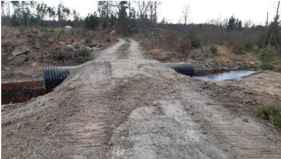
Figur 30. I norra delen av våtmarksytan gick en befintlig väg. Denna behövde höjas och trumman byttes till en större dimension med tanke på att dämningnivån skulle hamna en bit upp i röret.
