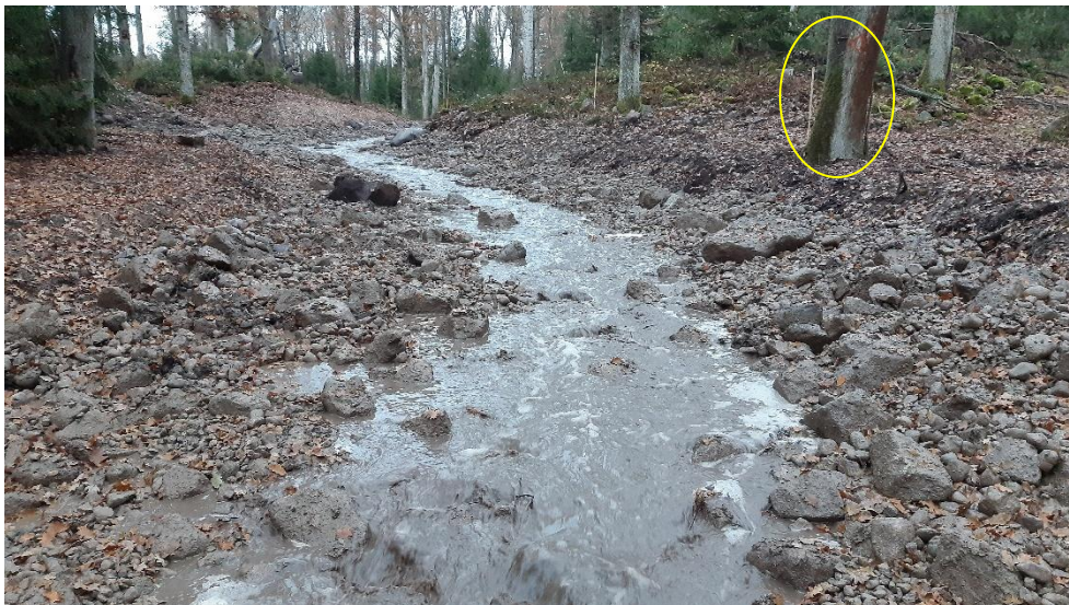
Figur 44. Ungefär samma vy som ovan, när det uppdämda vattnet precis släppts på i nygamla fåran (färgen beror på att stenmaterialet var lerigt). Början av november 2023
