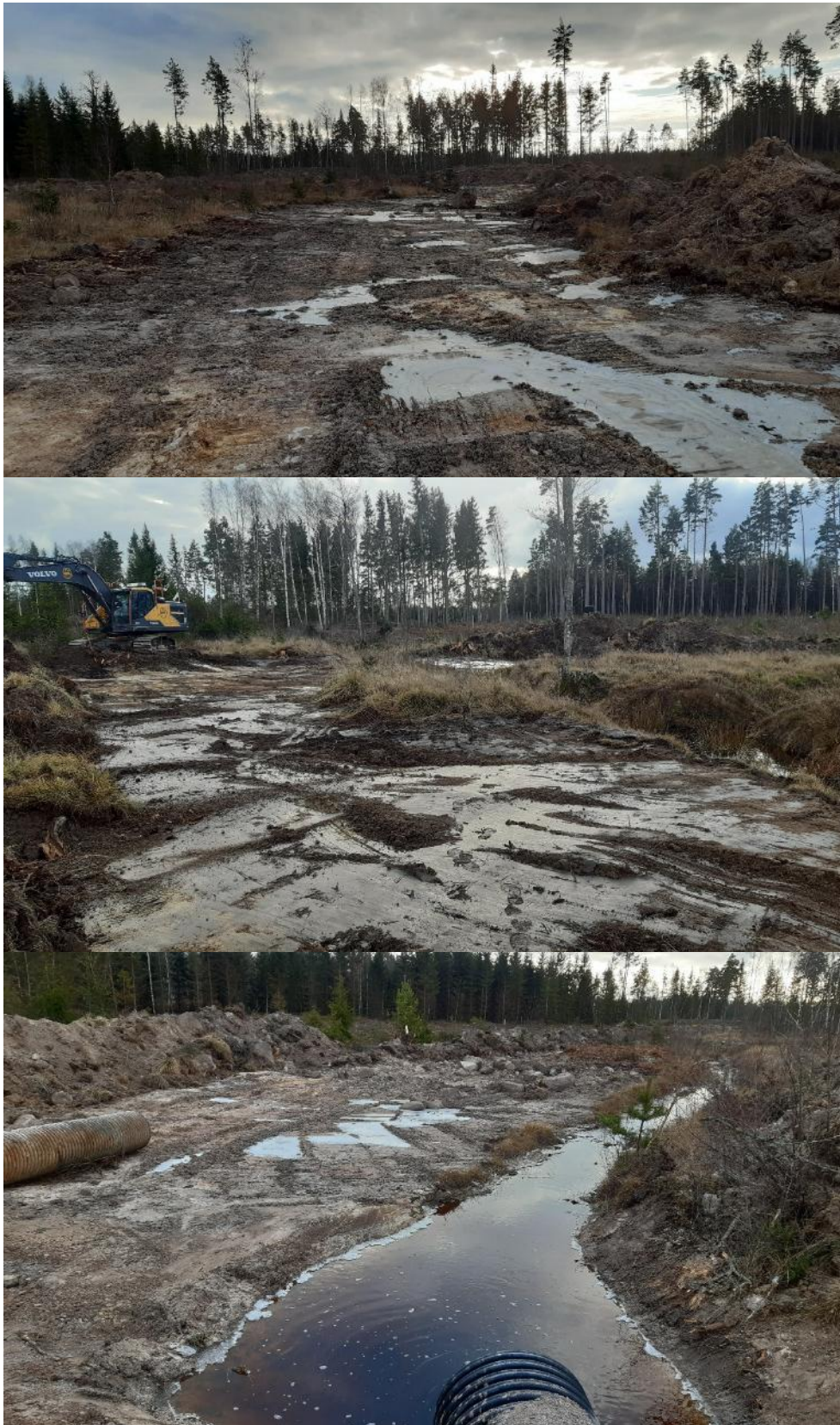
Figur 29. Tack vare torra och kalla vinterförhållanden (tjäle) kunde våtmarken grävas vintertid. En del av ytskiktet sparades för att få en viss mosaik av öar, som delvis var grävvallar från den tidigare dikningen. Det befintliga diket mitt i ytan ledde förbi det vattenflödet som kom under tiden.
