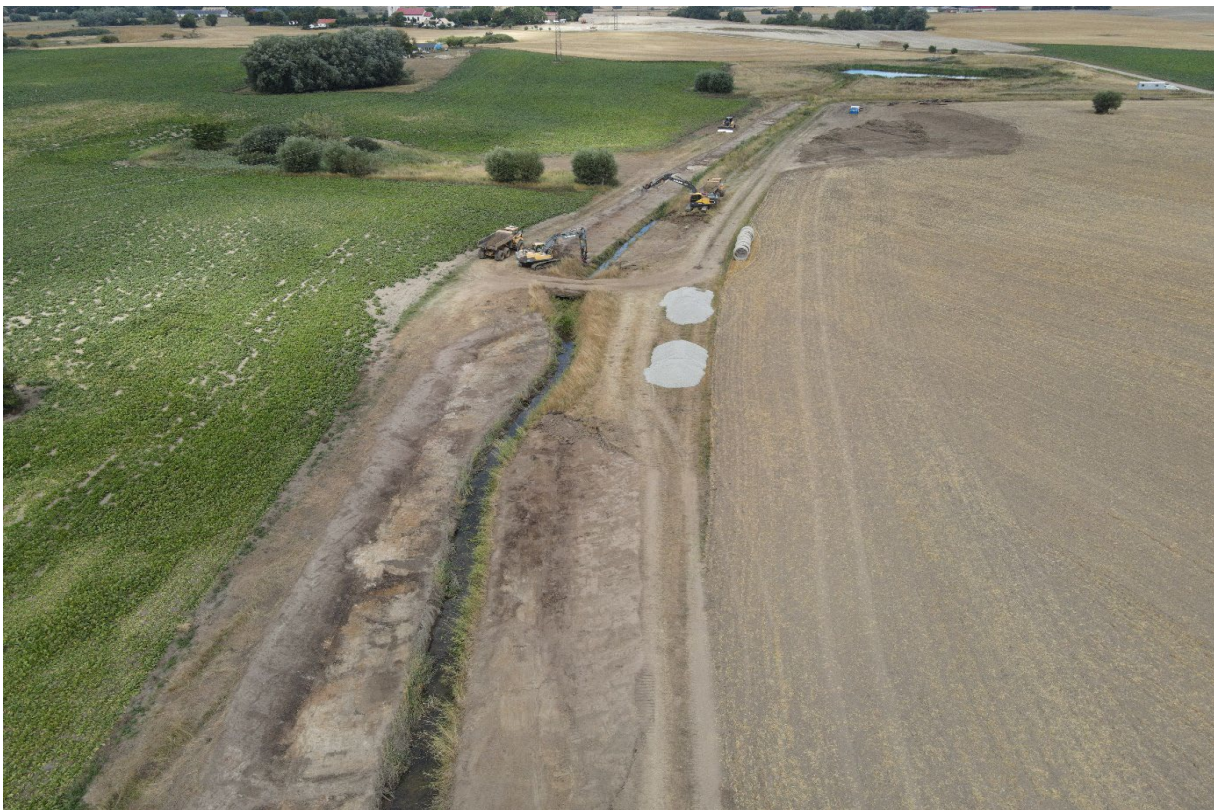
Bild 6: Tvåstegsdike på gång, vy från drönare.
