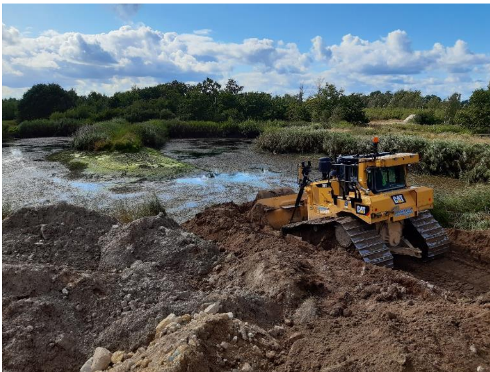
Figur 13. Något nervöst moment när de siltiga/sandiga moränmassorna från våtmarkens djuphålor skulle användas för att bygga en vall i den nästan torrlagda dagvattendammen (som var mycket mjuk i botten).
