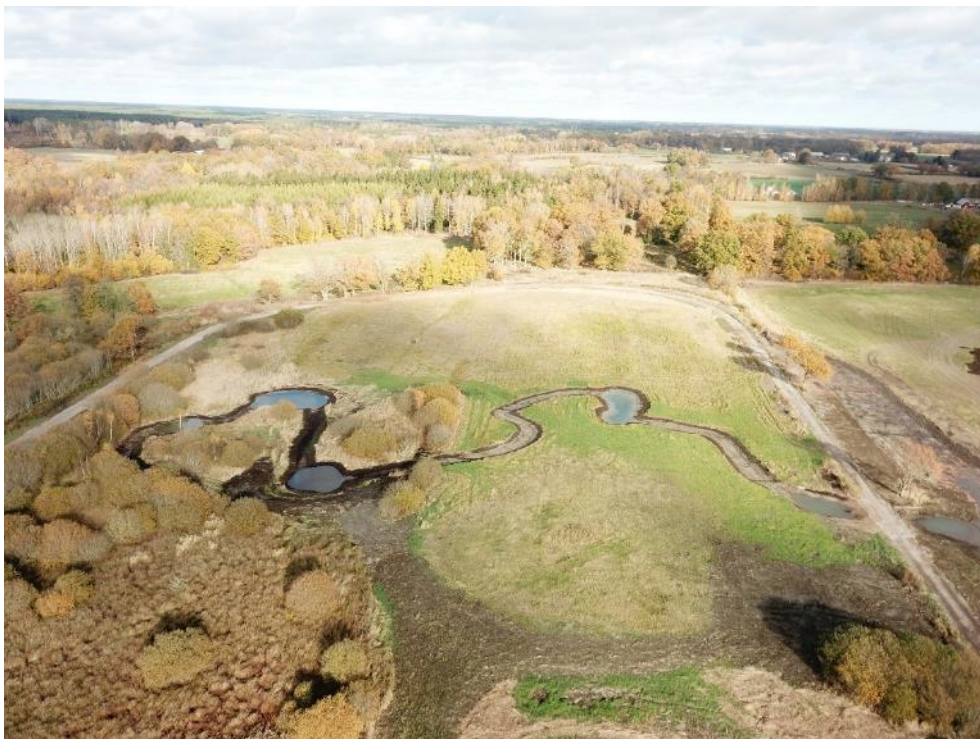
Figur 47. Vy över norra delen av fåran som grävdes innanför ridbanan för att garantera fria vandringsvägar för fisken. Annars hade det på vissa partier genom den öppna markytan blivit väldigt grunt (enstaka centimeter) vid låga flöden. Dock grävdes inte den mellersta delen av fåran eftersom marken var lägre där. Djuphålor i fårans sträckning grävdes för att ha kvar små oaser om/när våtmarken torkar ut.
