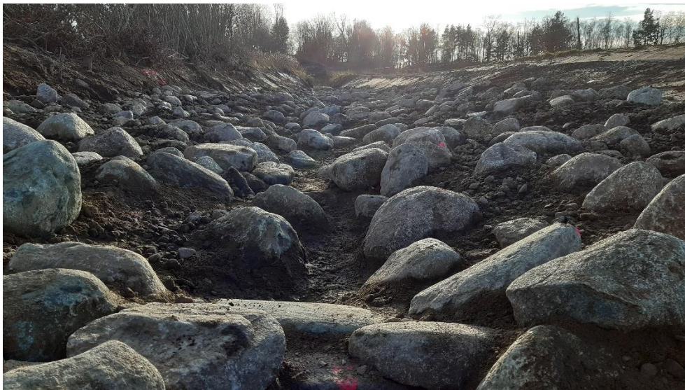
Figur 48. En fisktrappa/faunapassage med smal lågvattenfåra och en väldigt tilltagen högvattenfåra anlades vid våtmarkens utlopp. Att den blev så bred berodde på att diket var väldigt brett på en sträcka.
