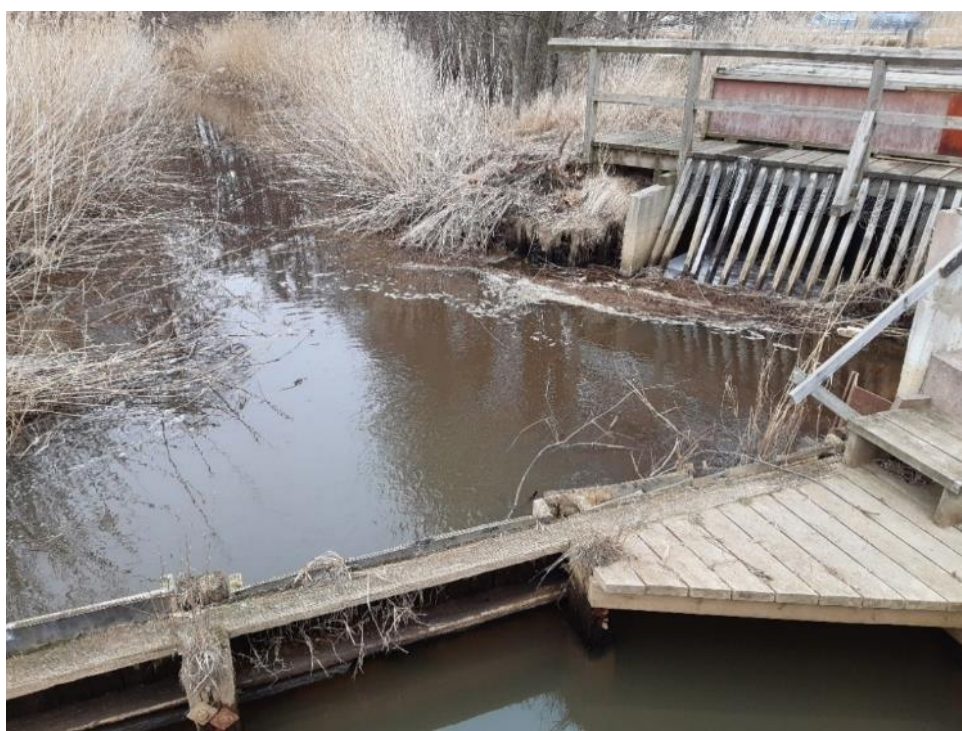
Figur 4. Fördämningen i Törnebybäcken (nederkant) vid intaget till Kalmar dämmes pumpstation (uppe t.h.). De breda öppningarna i gallret var inte framtagna med hänsyn till fisk.
