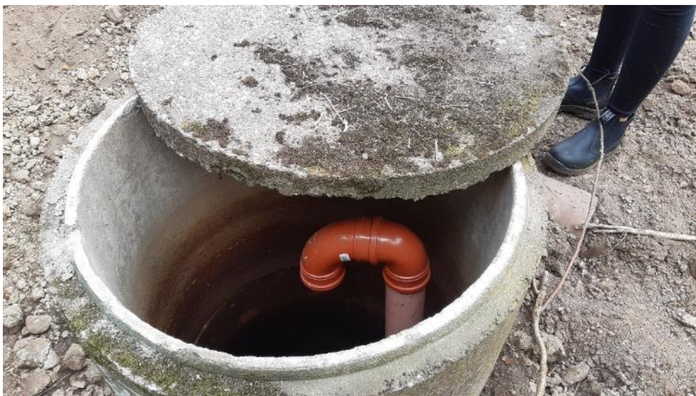
Figur 24. Genom ett relativt enkelt ingrepp gjordes dräneringsbrunnen om till en dämningsbrunn, där högsta vattennivån sattes med hänsyn till ekarna runt våtmarken.
