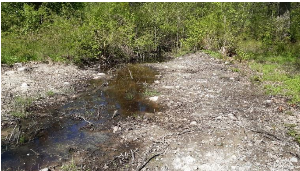
Figur 35. Även med diket igenlagt upp till omgivande mark blir det tidvis ett överskott av vatten som lämnar området. Maj 2024
