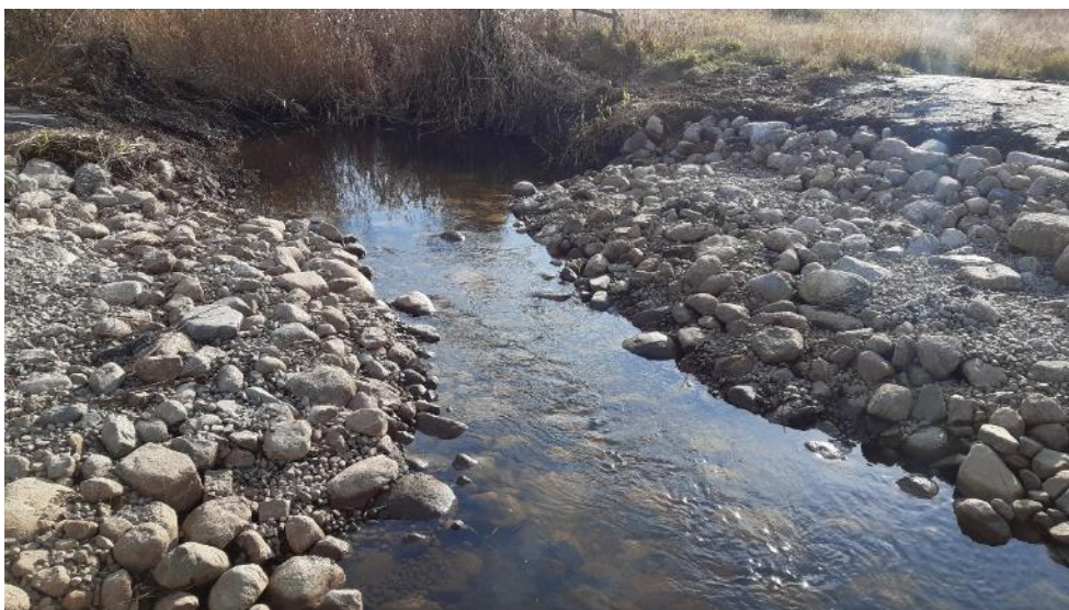
Figur 8. Den nya stentröskeln vid normalt vattenstånd i havet.
