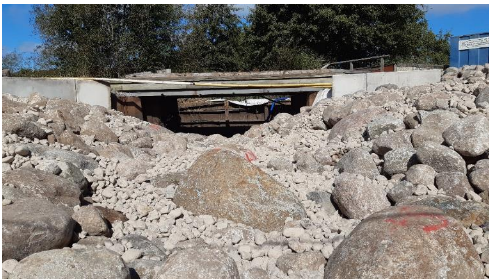
Figur 7. Den nya stentröskeln med det gamla trädämnets i bakgrunden (bakom bron)
