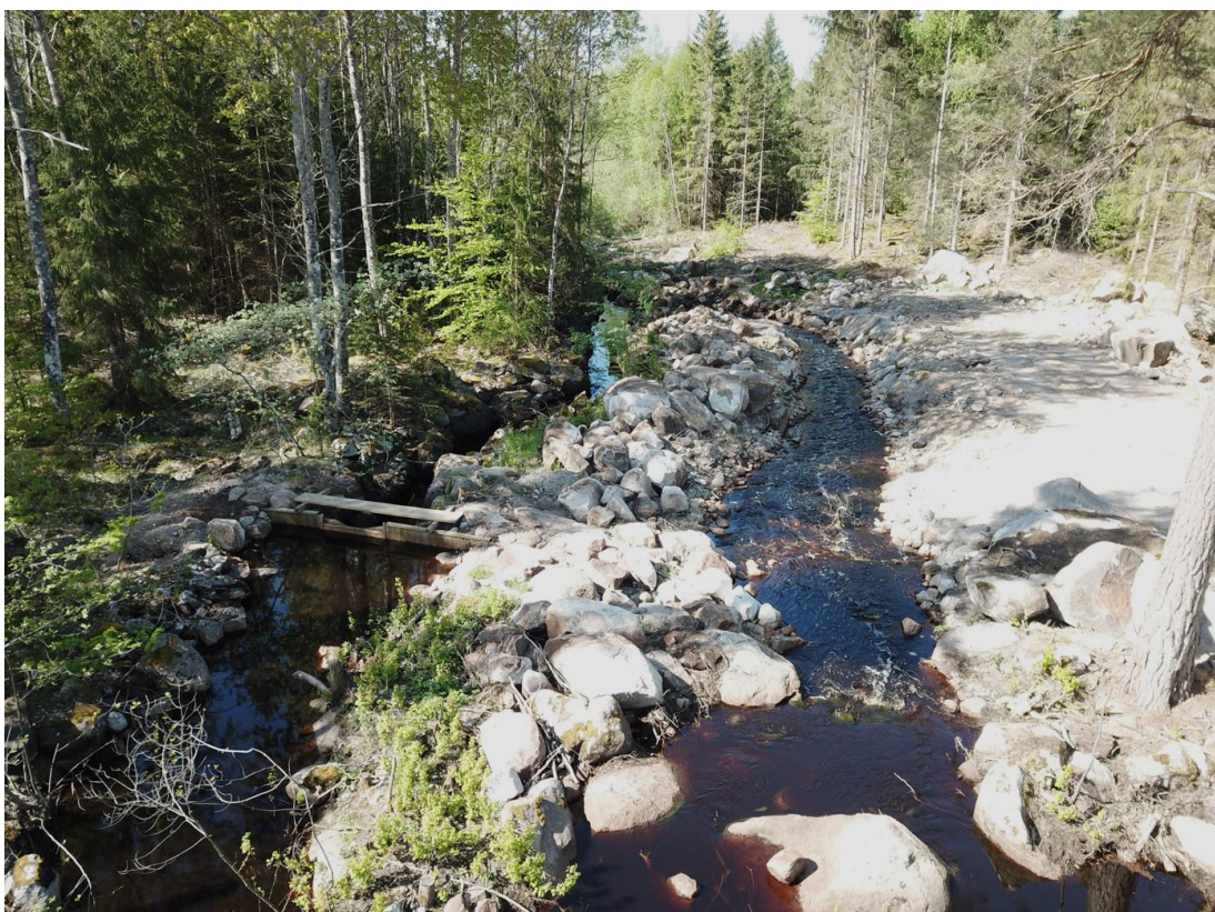
Figur 6. Dämme i det gamla diket till vänster och omlöpet till höger, vars tröskel mot våtmarken ligger en meter högre än dikesbotten intill. (maj 2024)
