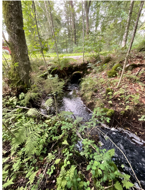
Figur 6 visar nedströms del av den grävda fåran. Strax uppströms trumman ansluter den naturliga fåran.
