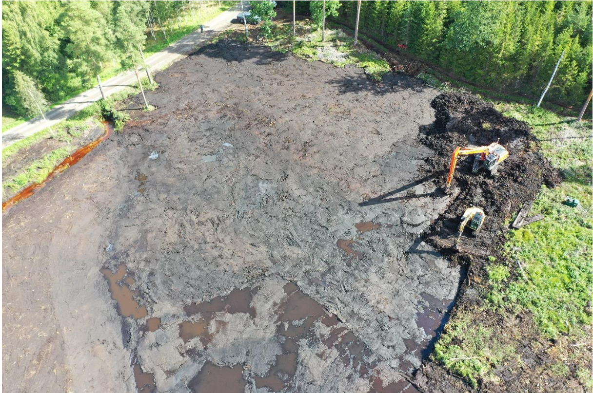
Pågående arbete aug 2023
