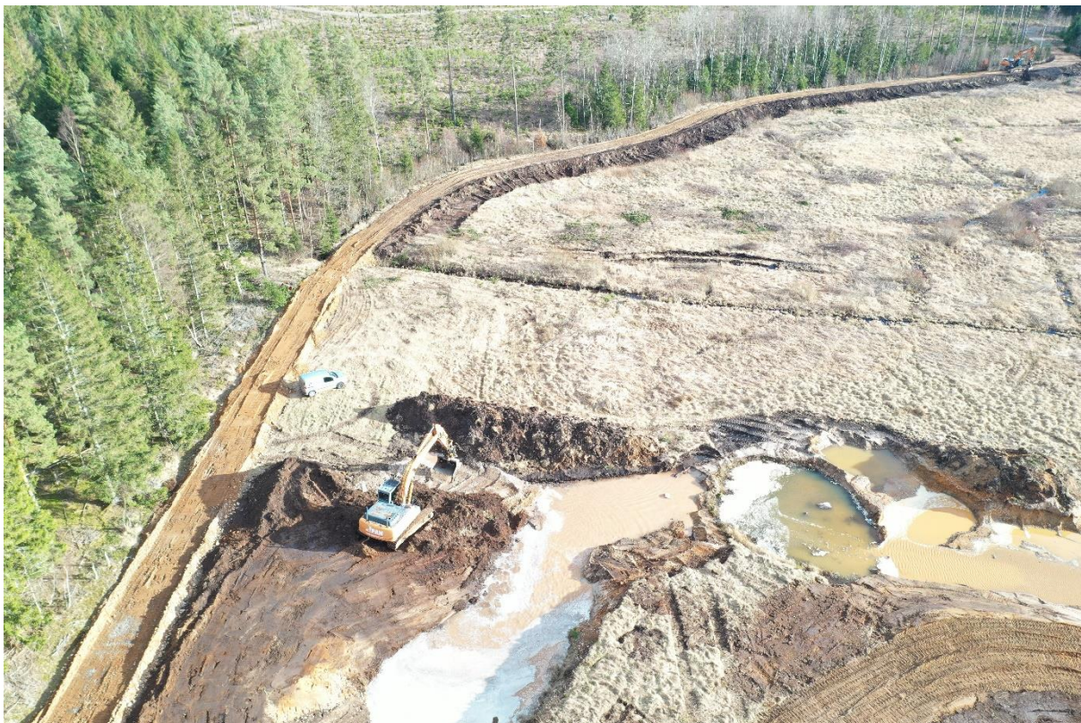
Pågående arbete med höja väg. Feb 2023
