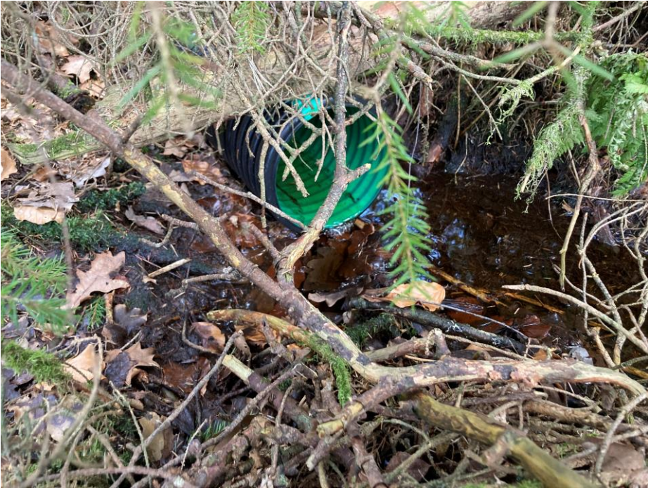
Utlopp 2, kulverterat under skogsväg. Vattnet rinner ut på grannfastigheten som har en lärkplantering. Torkar upp redan i början av maj.
