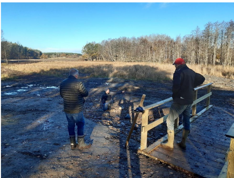
Figur 28. Slutbesiktning med markägare. Våtmarken breder ut sig över tre fastigheter, varav en ägs av kommunen. Ett skötselavtal kommer upprättas mellan markägarna.
