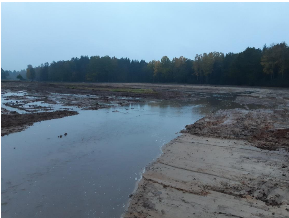
Figur 27. Vattnet släpps på vid inloppet på åkermarken där matjorden banats av. Mitt i har en ö lämnats för lite variation, vilket kan vara till glädje för tex sjöfågel.
