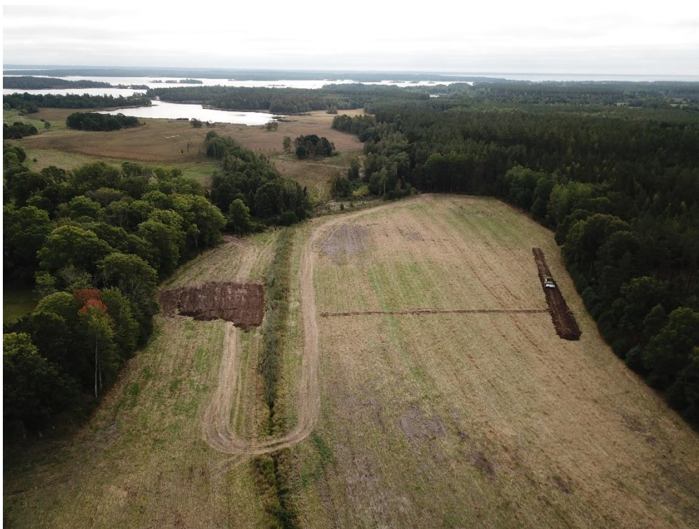
Figur 20. Drönbild tagen över det blivande våtmarksområdet. Vy mot sydost från det röda krysset i föregående bild. Diket syns mellan åkerbitarna och fortsätter i trädridan bortanför åkern. Schaktning precis påbörjad.
