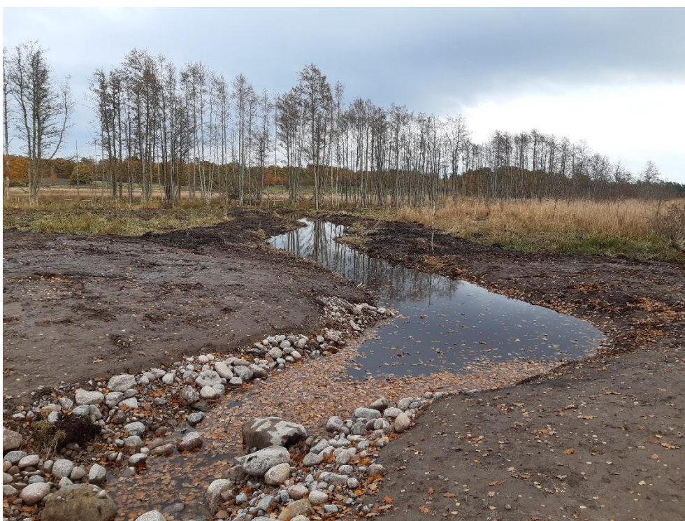
Figur 25. Utsidan av vallen där fisktrappan slutar. Ett meandrande dike skapades för att ansluta till befintligt dike (i trädriddån) som mynnar i kusten.
