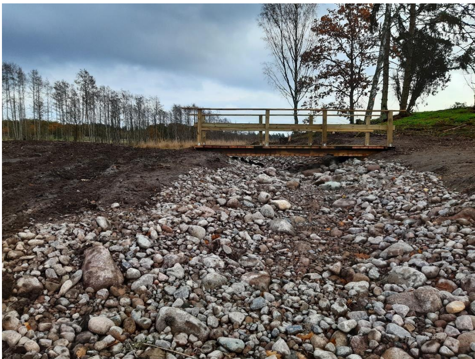
Figur 24. Det färdiga utloppet - en fisktrappa som ska möjliggöra att fisk såsom gädda kan ta sig in och leka i våtmarken.
