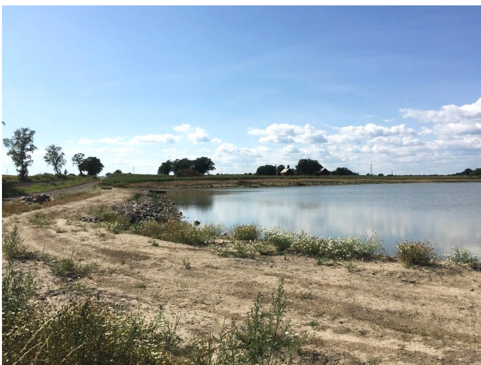
Figur 18. Vy mot sydväst från utloppet. Östra stranden är ofta vågexponerad varpå markägaren behövt läggs dit en del sten för att skydda mot erosion.
