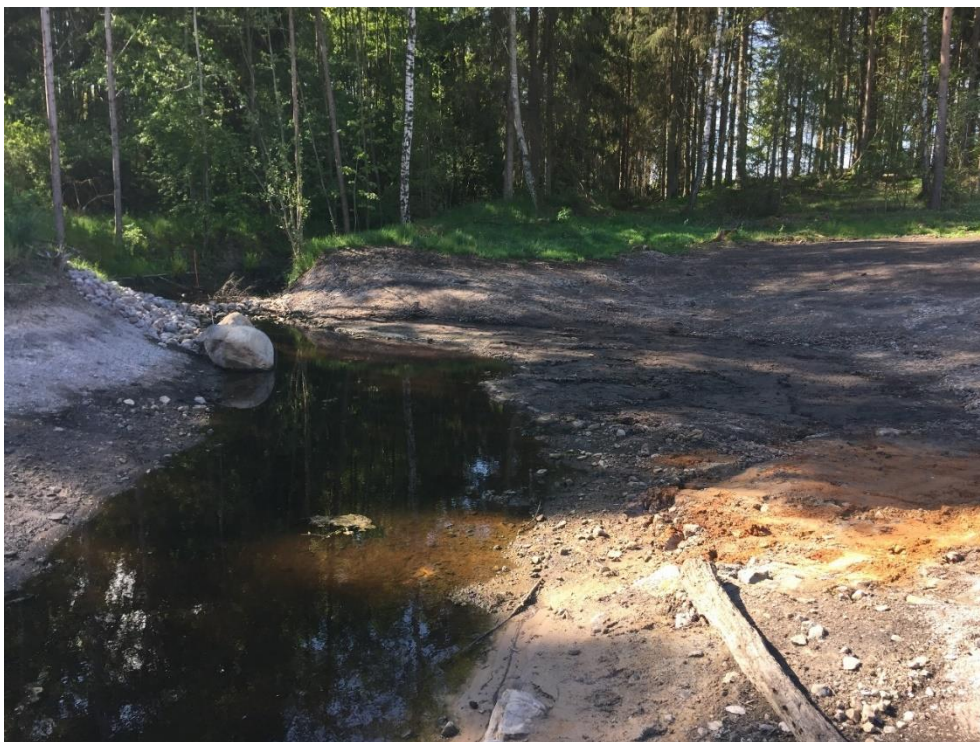
Figur 14. Precis efter inloppet skapas en breddning för att lugna ner flödet från Surrebäcken innan djuphålan. Det skapar också möjlighet för vilt att enkelt närma sig vattnet från skogen. Bilden tagen vid lågvatten.
