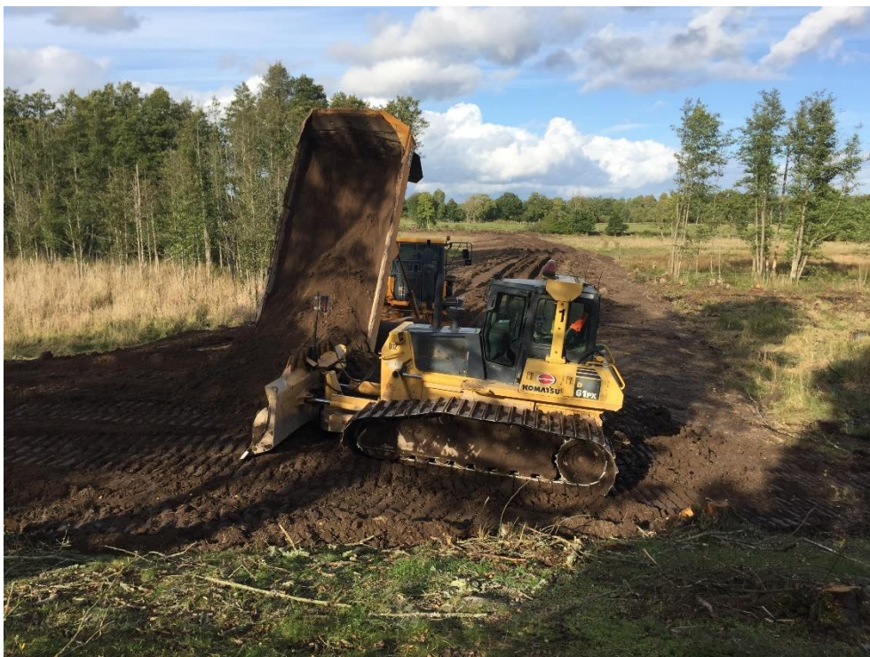
Figur 22. Här anläggs vällen, som dämmer inne vattnet och utgör våtmarkens östra gräns. Vallen anlades tvärs över diket, i samma linje som den lilla skogförsedda ön på bilden innan.
