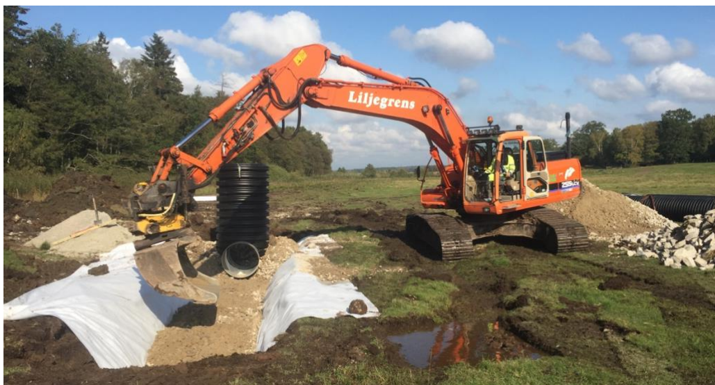
Anläggningsfas av en av Sportfiskarnas våtmarker. En låsbar regleringsmunk sattes in vilket innebär att nivån i våtmarken kan regleras, ifall till exempel ytterligare åtgärder behöver göras. Den fungerar också som bräddtröskel vid mycket höga flöden.
