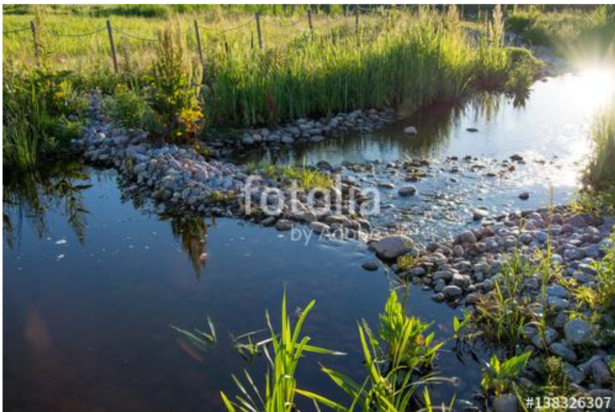
Strömnacke vid den restaurerade våtmarken vid Hemmesta sjöäng. Nacken består av en nedtryckt plastspont som täckts med natursten.
