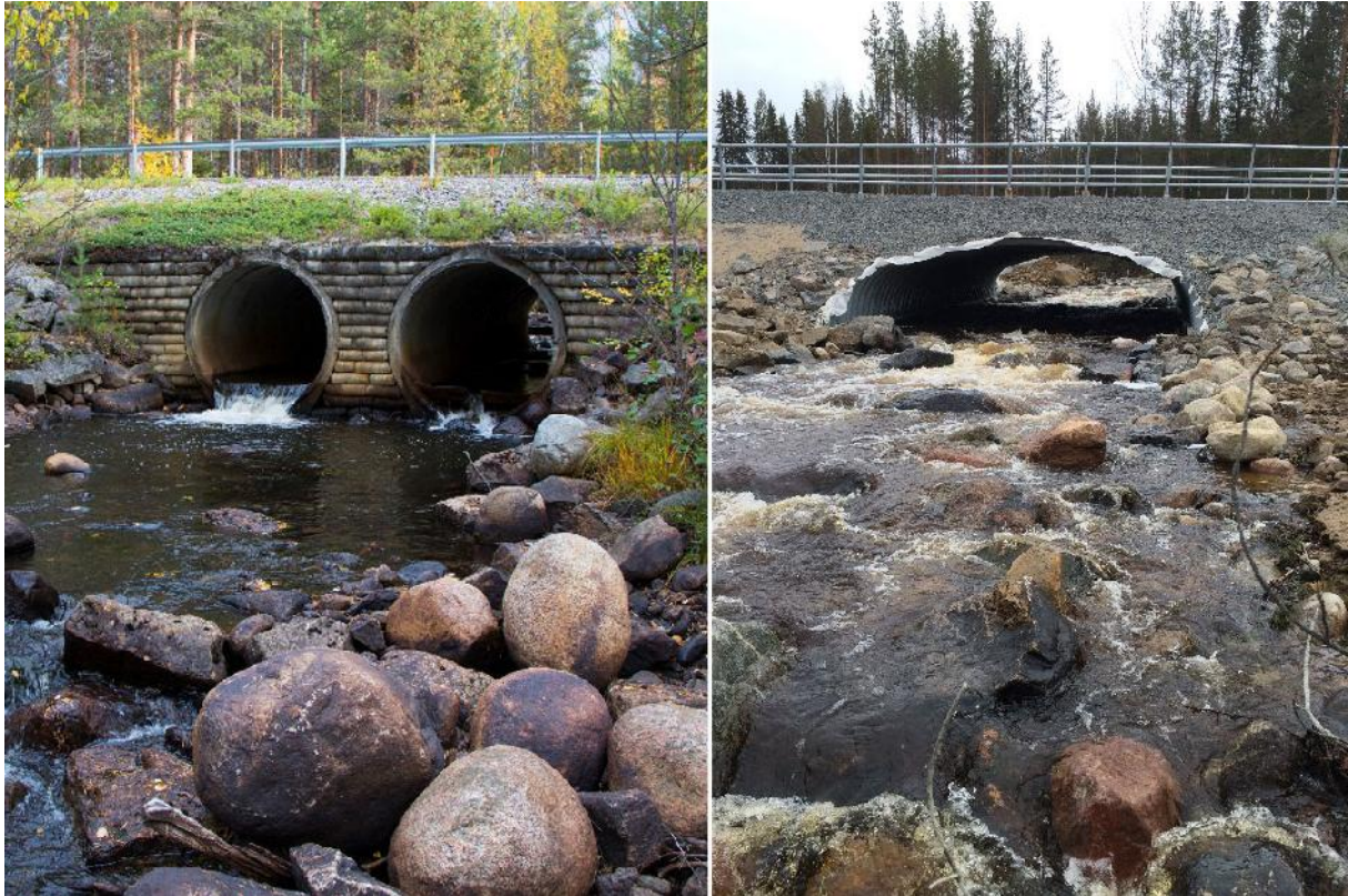
Bild 6. Exempel på ett partiellt vandringshinder som ersatts med en strömsträcka. Bilderna är tagna från Havs- och vattenmyndighetens hemsida.
