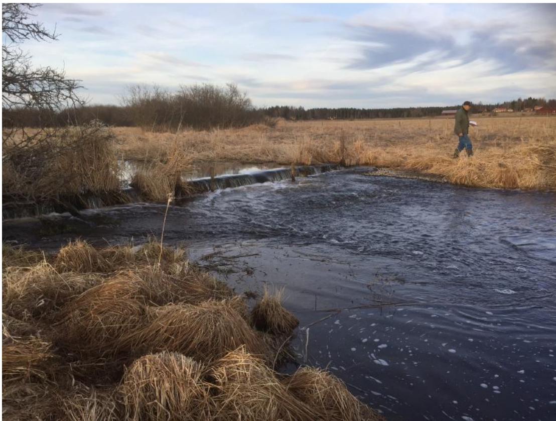
Bild 1. Dämmet nedströms Tegelsmorasjön den 9 april 2017. Bilden är tagen från den västra sidan av ån.
