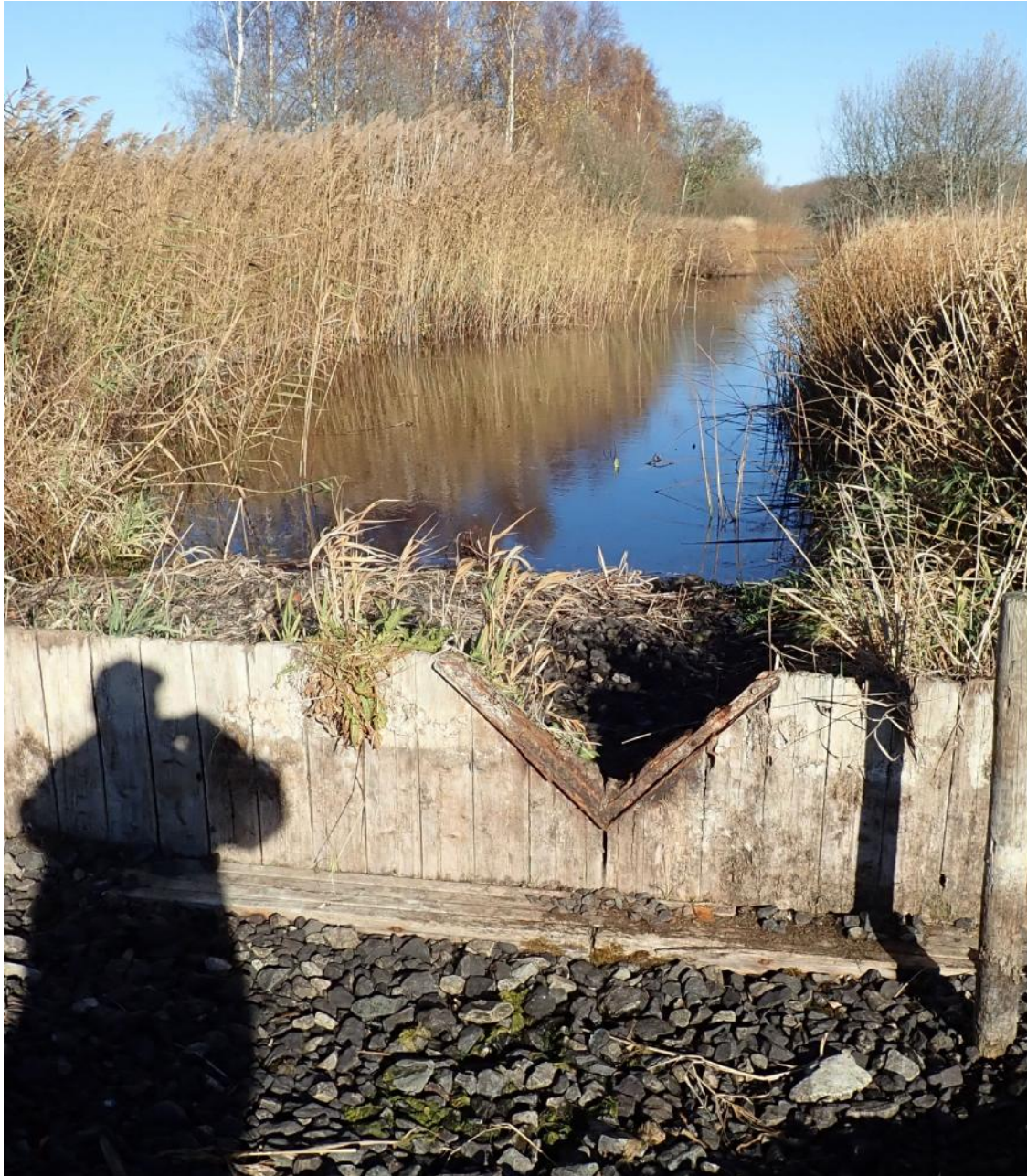
Bild 4. Utskovet på dämmet sett nedströms ifrån. V-överfallet upptill är 80 cm brett och 34 cm djupt. Dämmets bredd är cirka 14 m.
