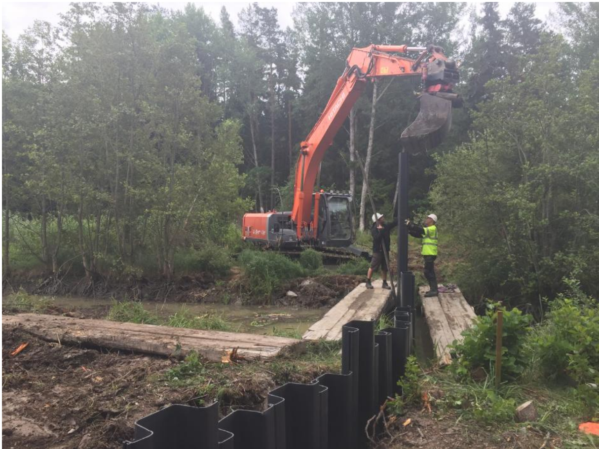
Bild 5. Arbetet med att trycka ned en plastspont i ett sjöutlopp i Södermanlands län. Foto: Michael Söderman.
