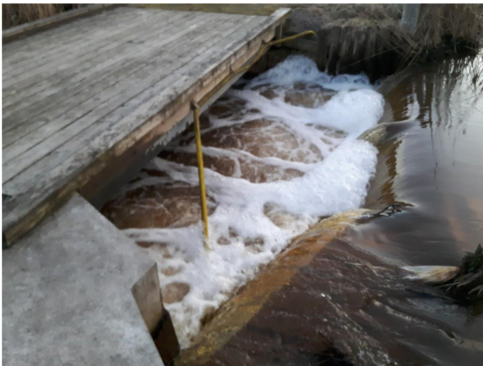
Figur 2. Fördämning i Törnebybäcken vid Kalmar Dämme. Bild: Johan Wegenke
