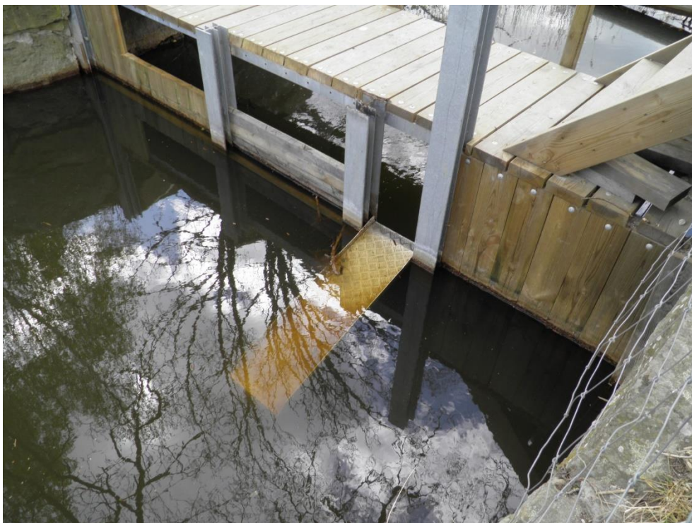
Figur 5 Exempel på fördämning med fiskramp som tillåter vandring.
